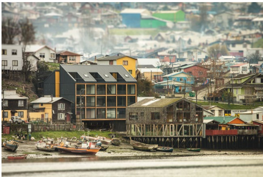
Imagen 4: Edificio Estación (fuente: © Federico Caironi, 2019)
