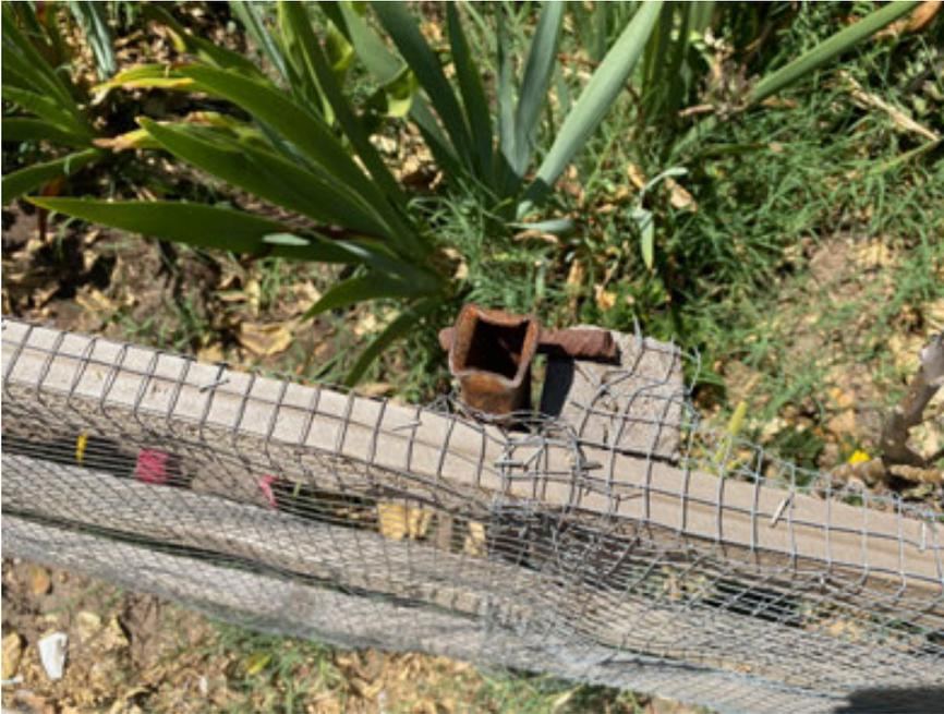
Imagen 16. Instalación de perfiles metálicos para entregar mayor solidez a la verja (fuente: Del autor,2022).
