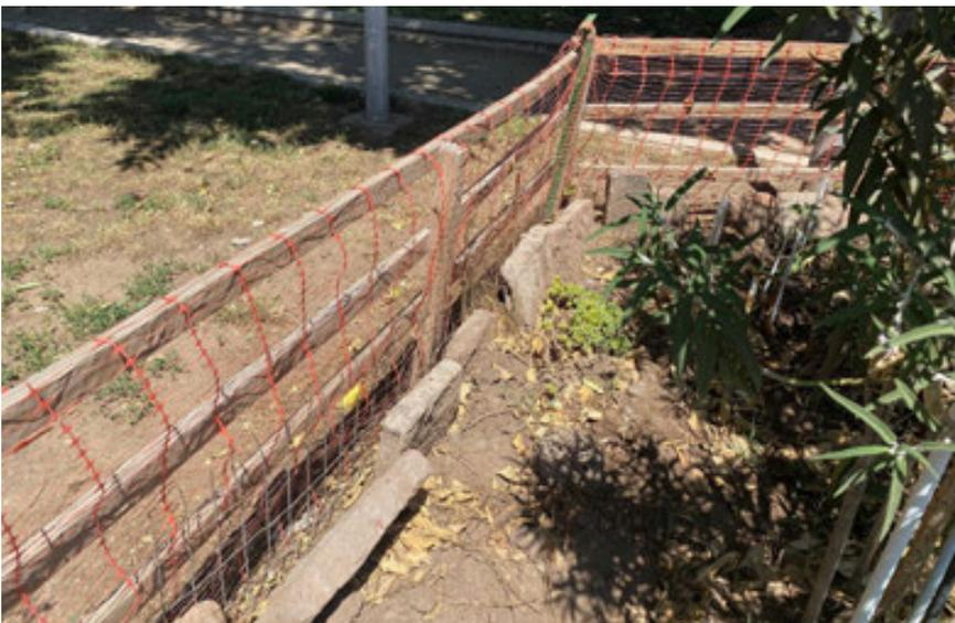
Imagen 18. Trozos de pastelones utilizados como solera de confinamiento ante su ausencia (fuente: Del autor,2022).
