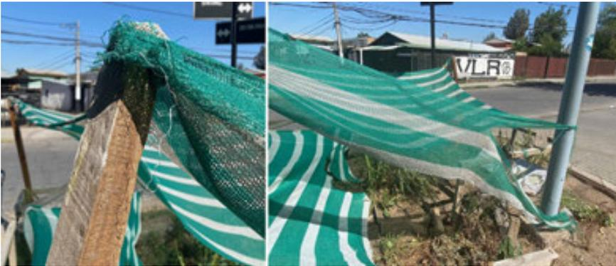
Imagen 4. Malla raschel amarrada a uno de los listones de pino y en el otro extremo a un poste (fuente: Del autor, 2022).
