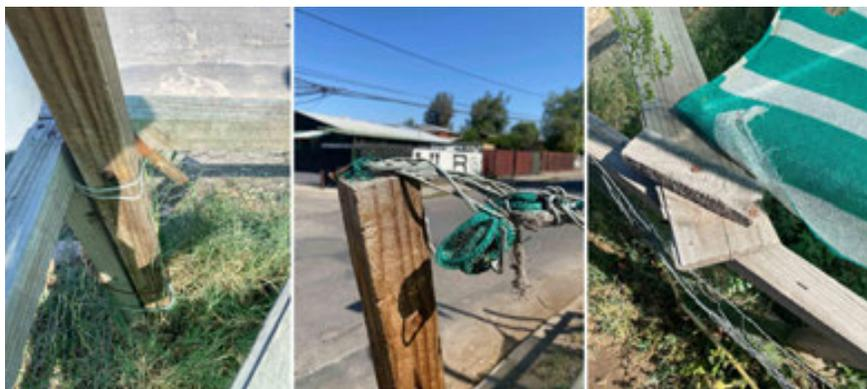
**Imagen 6.** Malla gallinero y malla *raschel* amarradas a los listones con alambre. Se utilizan esquineros como soporte de la estructura (fuente: Del autor,2022).
