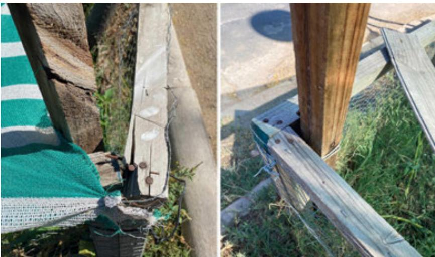
Imagen 5. Clavos y grapas en los listones que no cumplen una función en la intervención (fuente: Del autor, 2022).
