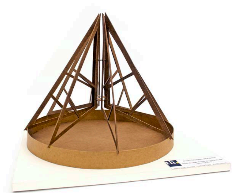
Imagen 13. Modelo de la estructura de techumbre del Pabellón Real de John Nash (fuente: María Cirano).
