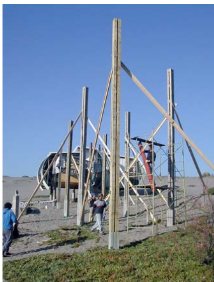
Imagen 4. Montaje y faenas de aplomo de uno de los pilotes estructurales (fuente: Archivo Histórico José Vial Armstrong, EAD-PUCV, 2014).
