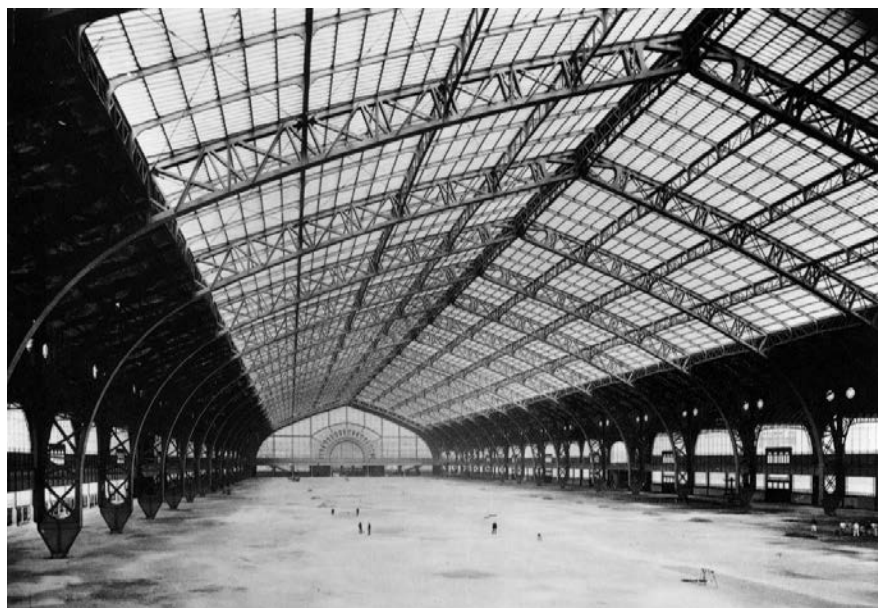
Imagen 7. Vacío interior de la gran nave central del Palais des Machines de la Exposición Universal de París de 1889, del arquitecto Charles Louis Ferdinand Dutert (1845-1906) y el ingeniero Victor Contamin (1840-1893) (fuente: Giedion, S., Georgiadis, S., 1995. Building in France, building in iron, building in ferro-concrete . Getty Center for the History of Art and the Humanities, Santa Monica, p. 140).
