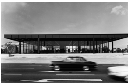
Imagen 11. El espacio arquitectónico como espacio interior en continuidad con el exterior definido por dos planos horizontales. Vista de la Neue Nationalgalerie de Berlín de Mies van der Rohe (1962) desde la Potsdamer Straße (fuente: Jäger, J., 2001. Neue Nationalgalerie Berlin : Mies van der Rohe. Hatje Cantz, Ostfildern, pp. 1-2).
