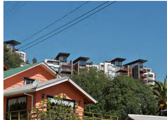
Imagen 5. Edificios del condominio Costa Mai en Maitencillo (fuente: Cristian Villagrán).
