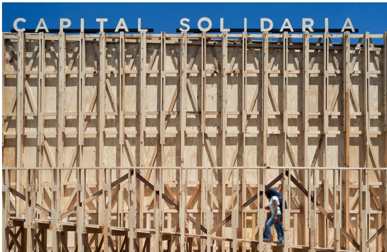
Imágenes 6 y 7. Vista de la estructura prefabricada en madera (fuente: el autor, 2014).
