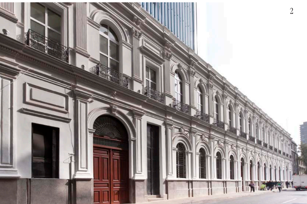
Imagen 2_ Fachada del antiguo Palacio Zañartu (fuente: el autor).
