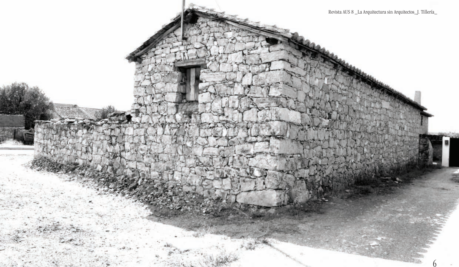
Imagen 6_Arquitectura tradicional, Patones de Abajo.
