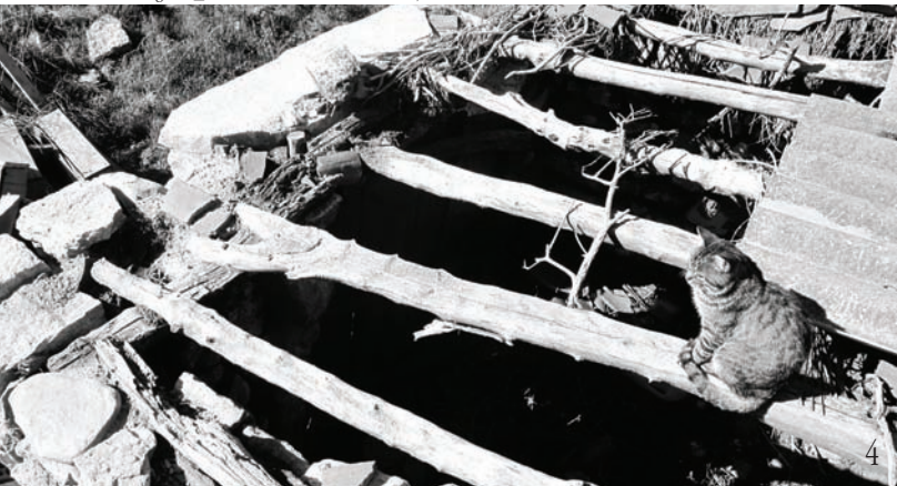
Imagen 4_Detalle sistemas constructivos, El Berrueco.
