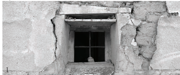
Imagen 2_Muro de fábrica de piedra, detalle ventana.
