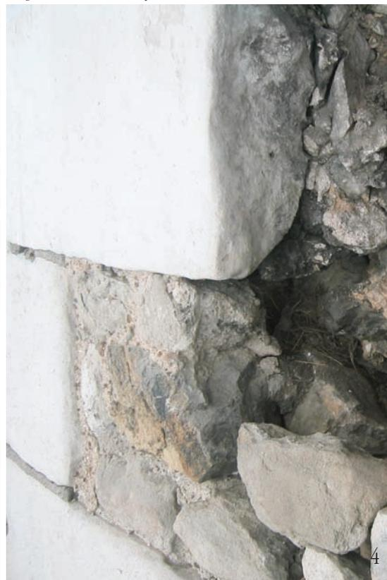
Imagen 5\_Fractura de piedra por elementos metálicos.
