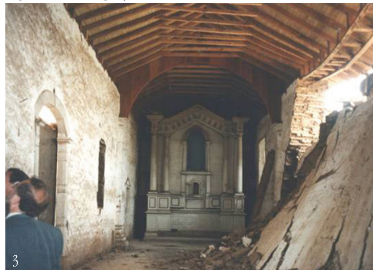
Imagen 4_Reconstrucción de la nave principal
