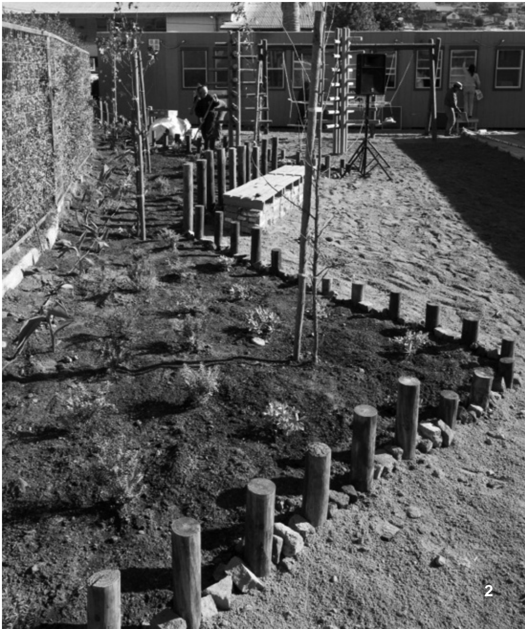
Imágenes de 1 a 6, vistas de la obra.
