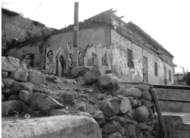
Imagen 5. Edificio deshabitado (fuente: El autor).
