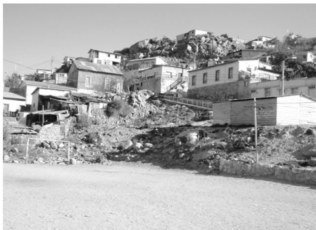
Imagen 6. Espacio urbano en proceso de deterioro (fuente: El autor).
