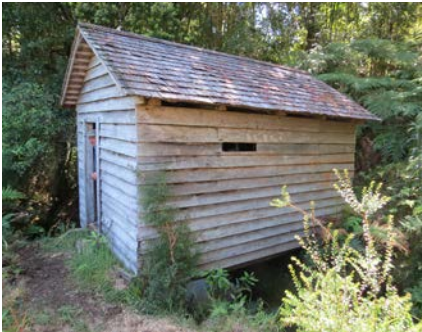
Imagen 6. Molino chilote suspendido en troncos enterrados. El entablado de los muros deja solo unas cuantas ranuras a modo de iluminación, evitando que el viento se lleve la harina. Las tejas de alerce constituyen un rasgo marcadamente chilote (José Bravo 2014).
