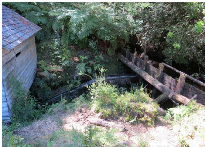
Imagen 4. Estanque de alimentación o tranque, desde el cual se precipita el agua permitiendo el funcionamiento del molino (fuente: José Bravo 2014).
