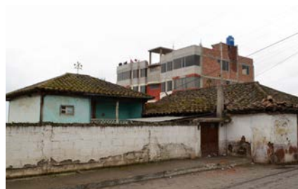
Imagen 26. El contorno de los tejados de las casas patrimoniales 17 y 18 aparece interrumpido por el "relleno" de un edificio nuevo de cinco plantas (fuente: Daniel Díez).
