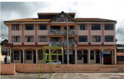
Imagen 8. Nuevo ayuntamiento de Tisaleo, construido en 1997 (fuente: Daniel Díez).
