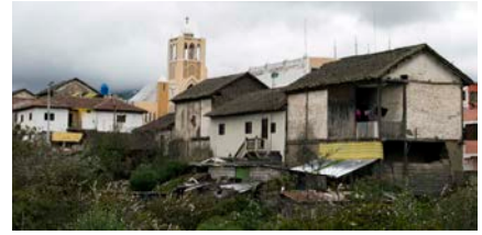
Imagen 14. Concentración de la calle Juan Montalvo, vista desde atrás (fuente: Iván Álvarez).
