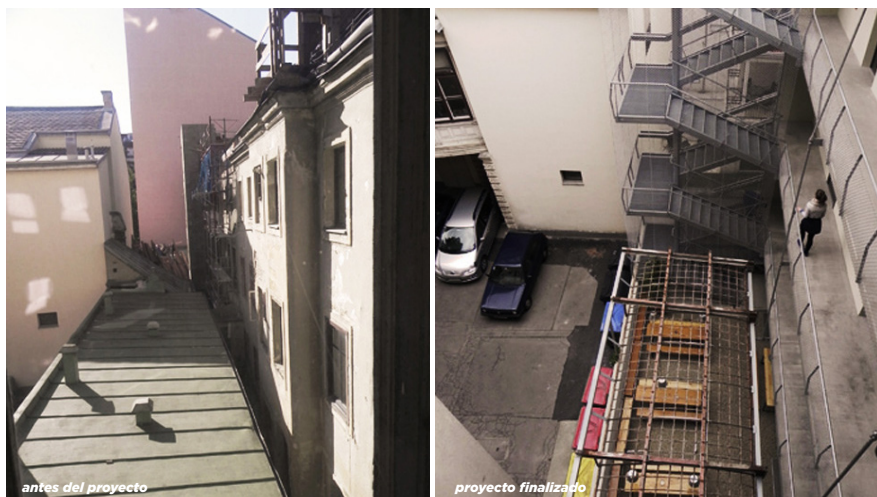
Imagen 2. Se conservó la estructura del techo de un antiguo taller, que ahora es una pérgola en el jardín del restaurante (fuente: La autora 2011 y 2013).
