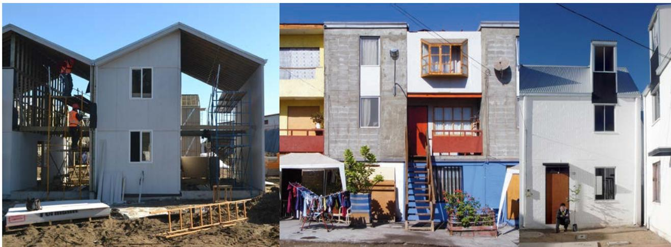
Imagen 5. ELEMENTAL. Casa ampliable, edificio paralelo y casa flexible (fuente: Aravena 2012).
