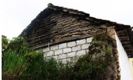
**Imagen 23.** Hastial de la vivienda número 24, donde se puede ver la estructura y componentes del bahareque en combinación con el bloque de hormigón (fuente: Daniel Díez).
