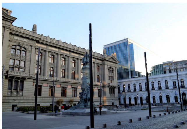
Imagen 4. Puesta en valor de las fachadas de El Mercurio y construcción de edificio de obra nueva que dialoga con el edificio de los Tribunales de Justicia. Santiago, Chile (fuente: Sánchez 2017).
