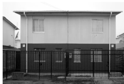
Imagen 5. Módulo de vivienda en Villa El Parque IV (fuente: Suazo 2016).
