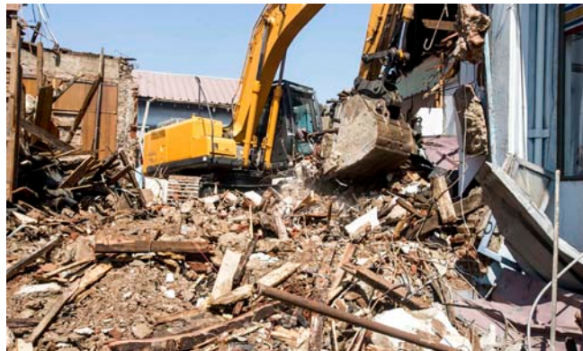
Imagen 8. Demolición del Ex Hospital Ferroviario del Cerro Barón de Valparaíso, lugar de alto valor patrimonial. En su reemplazo se instalan edificios de departamentos con vista privilegiada a la bahía (Fuente: Fidel Rudolffi 2014).
