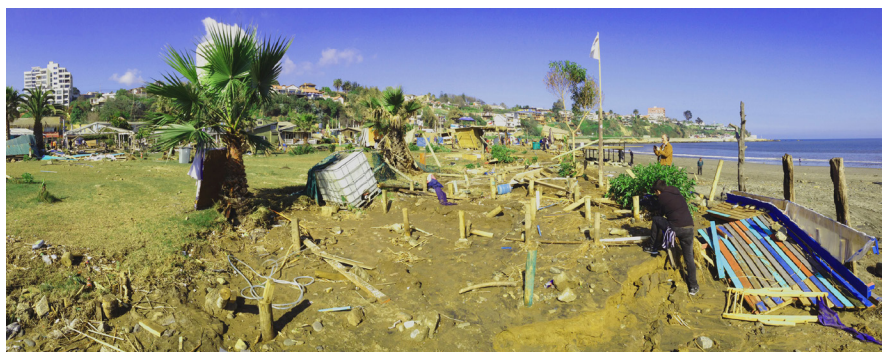
Imagen 4. Edificación destruida durante tsunami 2015, Sector La Boca, Concón (fuente: Patricio Winckler).
