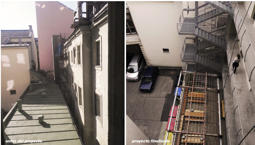
Imagen 2. Se conservó la estructura del techo de un antiguo taller, que ahora es una pérgola en el jardín del restaurante (fuente: La autora 2011 y 2013).
