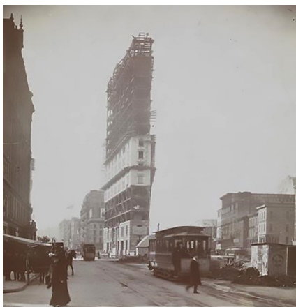
Imagen 1. Times Square, edificio en construcción (fuente: Byron Company, 1903).
