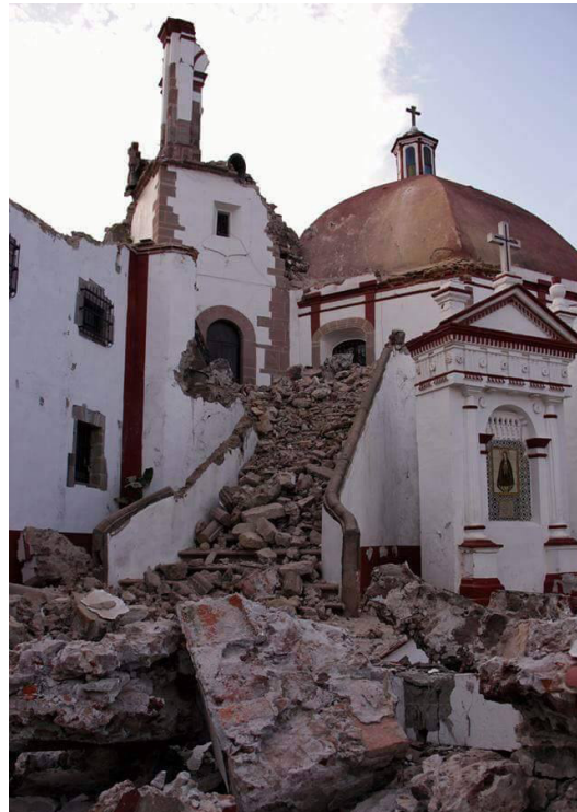
Imagen 5. Daños en la torre campanario y escalinatas (fuente: Cortesía de Eder Torres Villamar del Consejo Parroquial, 19 de septiembre de 2017).
