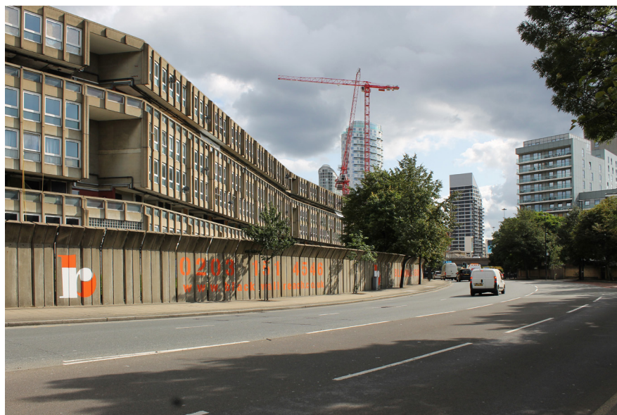
Imagen 2. Bloque oeste del Conjunto Robin Hood Gardens, en preparación para la demolición (fuente: Del autor, 2017).
