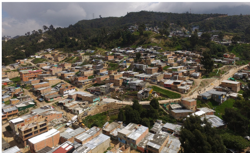
Imagen 1. Vista del borde urbano sur oriental de la ciudad de Bogotá. Zona de Sierra Morena, Usme. Asentamiento que durante más de 35 años no ha logrado formalizarse (fuente: Archivo de los autores, 2019).
