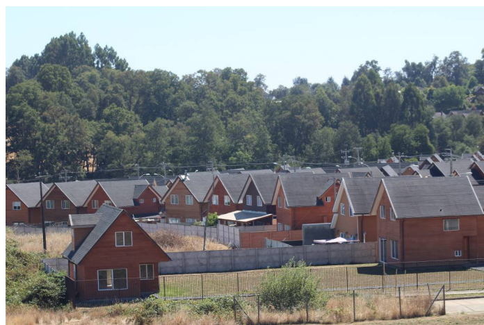
Imagen 9. Viviendas sociales (fuente: Del autor, 2022).
