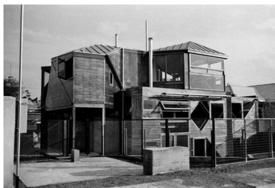
Imagen 4. Vista de la Casa en Jean Mermoz (1956-1961). En primer plano el cuerpo elevado de la habitación de servicio, donde se ve el triángulo cerrado de la cercha que define su fachada izquierda (fuente: Archivo Histórico José Vial Armstrong e[ad] PUCV, 1961).
