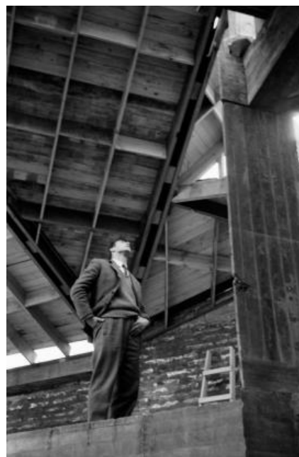
Imagen 1. Fabio Cruz ante un pilar durante la construcción de la Casa en Jean Mermoz (1959) (fuente: Archivo Histórico José Vial Armstrong e[ad] PUCV, 1959).
