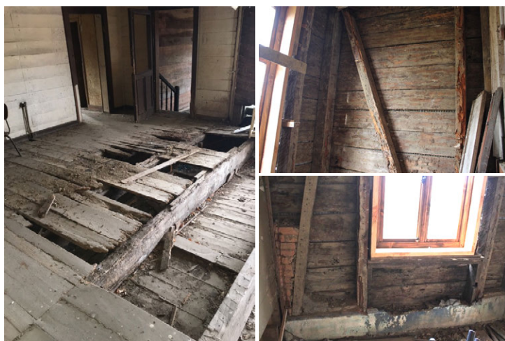
Imagen 6. Estado sistema estructural en 2º piso (fuente: de los autores, 2022).
