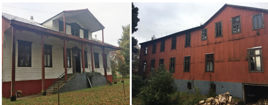
Imagen 1. Fachada poniente y sur de la casona Haverbeck (fuente: de los autores, 2022).
