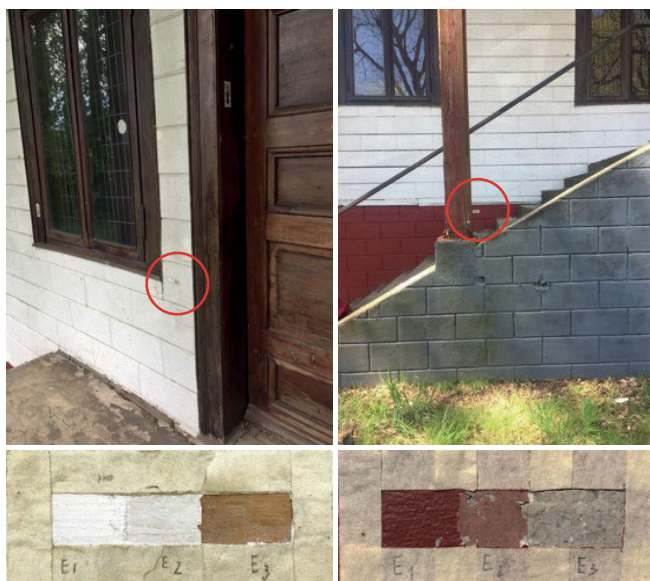
Figura 5. Diagnóstico estratigráfico de pinturas exteriores e interiores (muestra), (fuente: elaboración propia, 2022).
