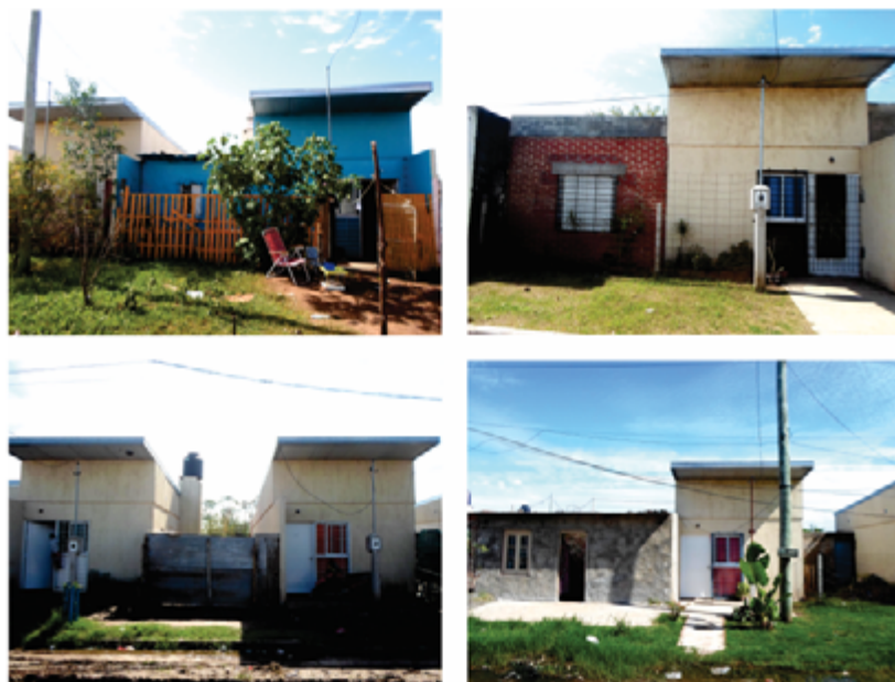
Imagen 1. Fotografías cotidianas de las viviendas investigadas (fuente: de la autora, 2018).
