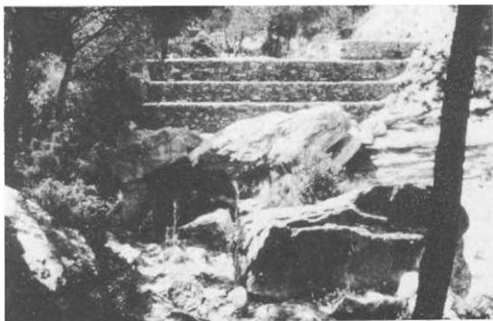
Figura 6. Foto desde aguas abajo de un dique tipo de mampostería de gaviones proyectado. Upstream picture of a projected gabion type dam.
