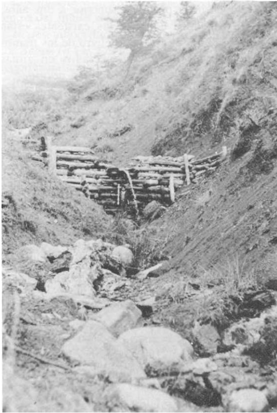
Figura 2. Foto desde aguas abajo de un dique de mampostería de trozas en el torrente Los Coigües. Upstream picture of a rock-filled log crib dam at Los Coigües torrent.
