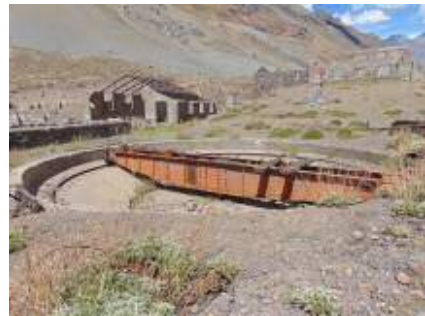
FIG. 12: De abajo hacia arriba: tornamesa, casa de máquinas, monolito y estación de Juncal
