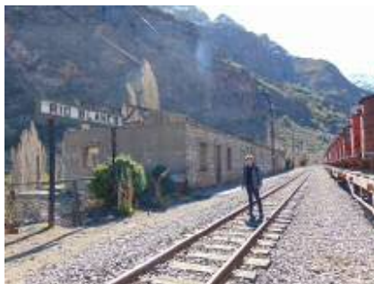
Fig. 10: Línea y edificaciones en la Estación de Río Blanco
