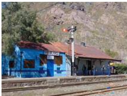
FIG. 9: Estación de Río Blanco
