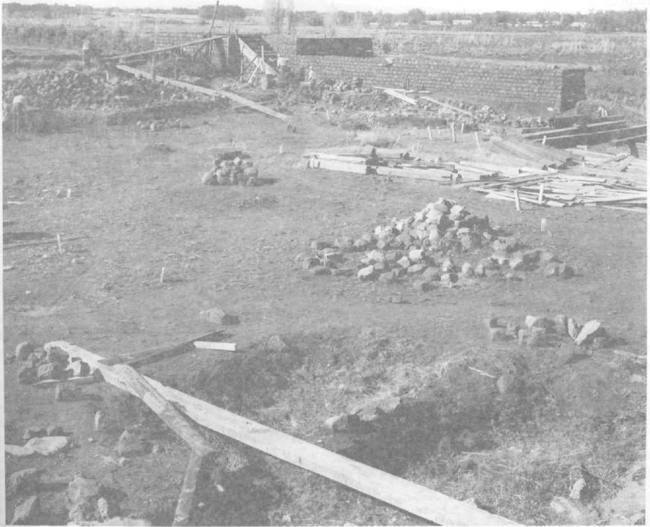
Explanada interior del castillo durante las obras. Fotografía tomada desde el cubo sur poniente hacia el del nor oriente, por D. Maurice van de Maele, 1968.
