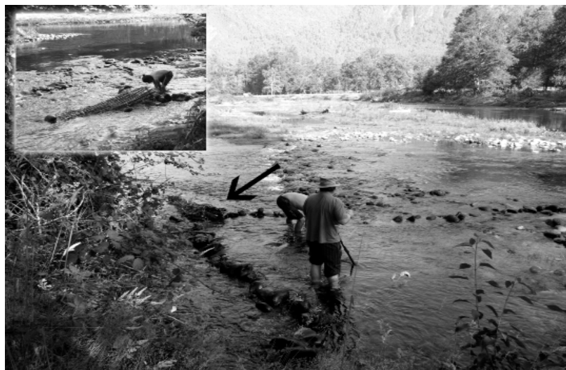
Figura 12. Instalación de llolle cónico en río (marcado con una flecha), utilizando muro de cantos rodados para orientar a los peces hacia la trampa (Llifén, comuna de Futrono, región de Los Ríos. Fotografía Diego Gálvez 2012)
