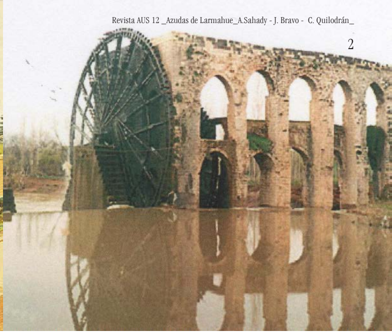
Imagen 2_ Las orillas del río Orontes, bordeadas de árboles y jardines, cuentan con una enorme azuda, que se construyeron hace siglos para abastecer a la ciudad de agua. Constituyen, asimismo, un eficiente mecanismo para controlar el riego, 2007 (fuente: http://www.qsl.net/ea5Surn/noria12.htm ).
