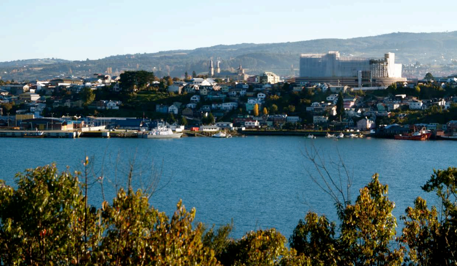
Imagen 2_ La Iglesia de San Francisco de Castro y su zona de amortiguación son parte de un Sitio del Patrimonio Mundial de Unesco desde el año 2000. El centro comercial en construcción que se aprecia en la foto está “afuera” de ese perímetro (fuente: Patricio Muñoz, 2012).
