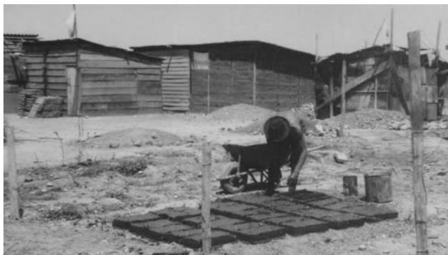
Imagen 9. Un poblador fabricando adobes (fuente: Sotomayor, 1958)
