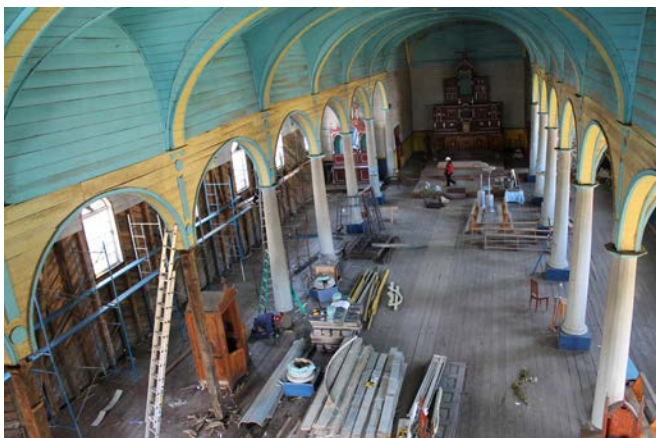
Imagen 1. Proceso de restauración patrimonial de la Iglesia de Rilán (fuente: Fundación Amigos de las Iglesias de Chiloé, 2012).
