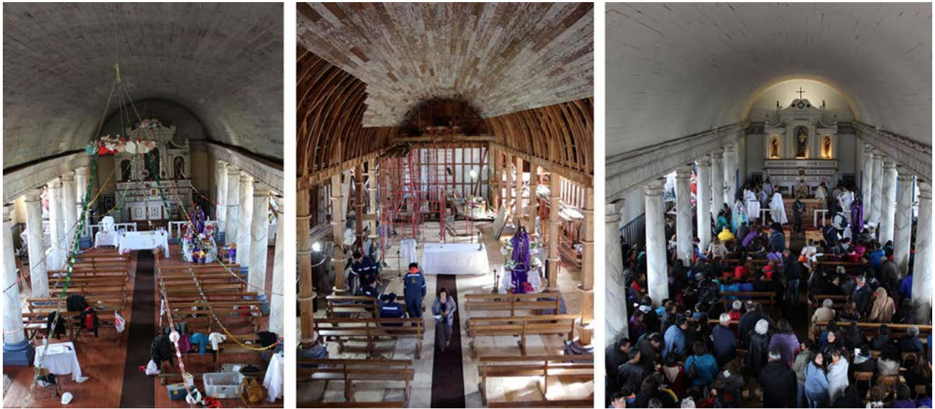
Imagen 7. Vista interior proceso restauración patrimonial Iglesia de Chelín (fuente: Fundación Amigos de las Iglesias de Chiloé, 2015):
