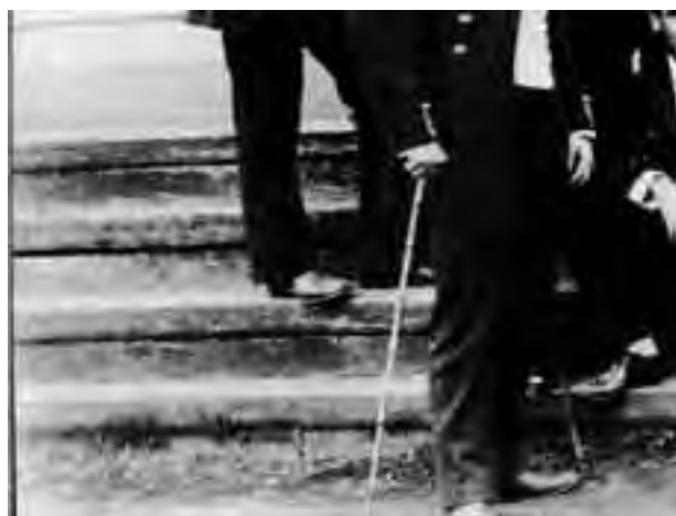
Figura N° 6. Detalle de la imagen anterior que muestra el entablado original que recorría todo el frente de la casona.
