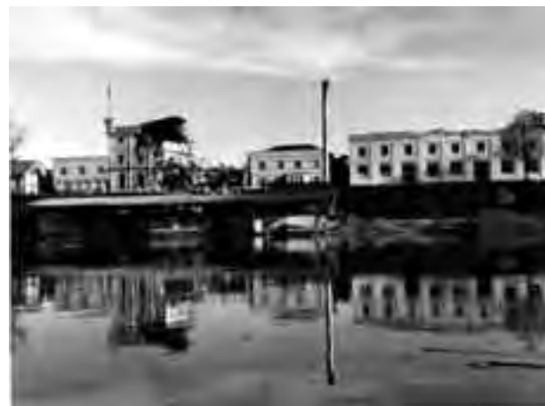
Figura N° 8. Fábrica después del terremoto, 1960.
